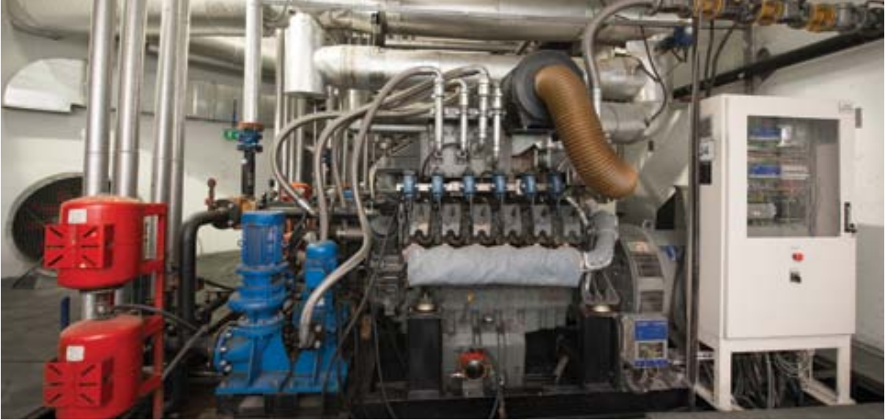
4 x 500 kWe Senkronize Doğalgaz Trijenerasyon Setleri
